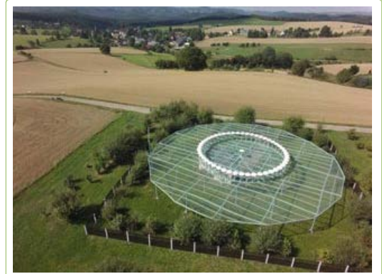
Flugsicherungsanlage von 1986 auf der Kuppe der Emmabank
